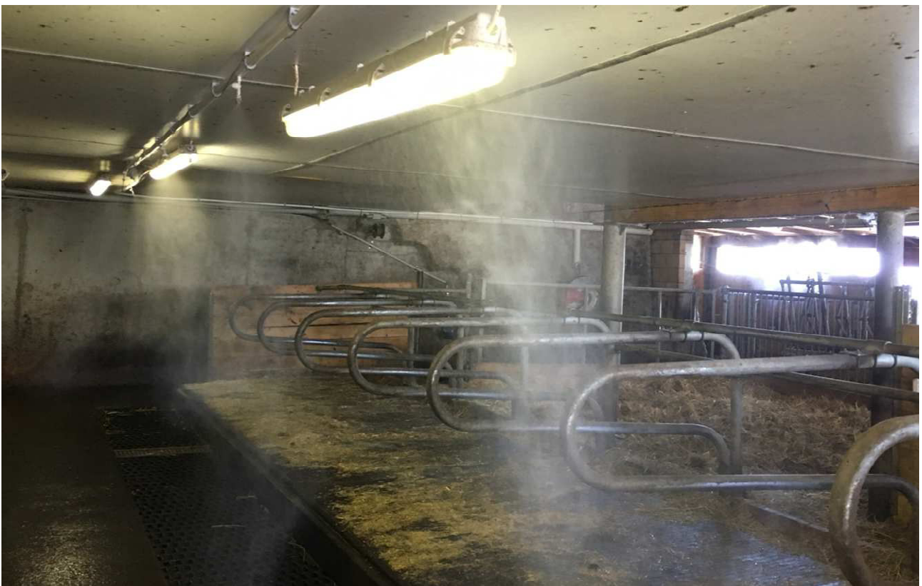
Teilbereich I der Vernebelung: Stallgang entlang der Liegeboxen
