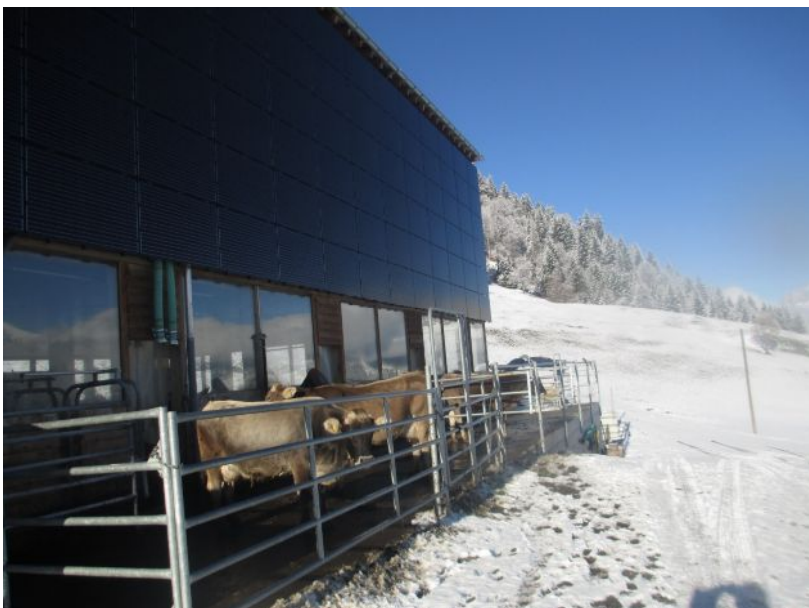
Solar Wand und Dach
